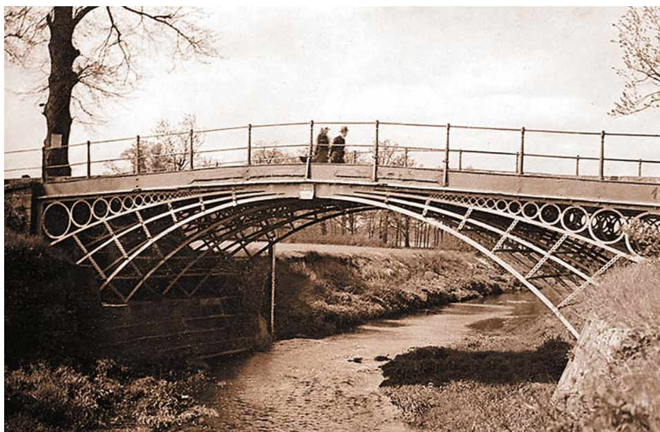
Most w Łażanach, pierwszy na kontynencie europejskim most żelazny, wybudowany na rzece Strzegomce w 1796 roku. Zniszczony podczas II wojny światowej
