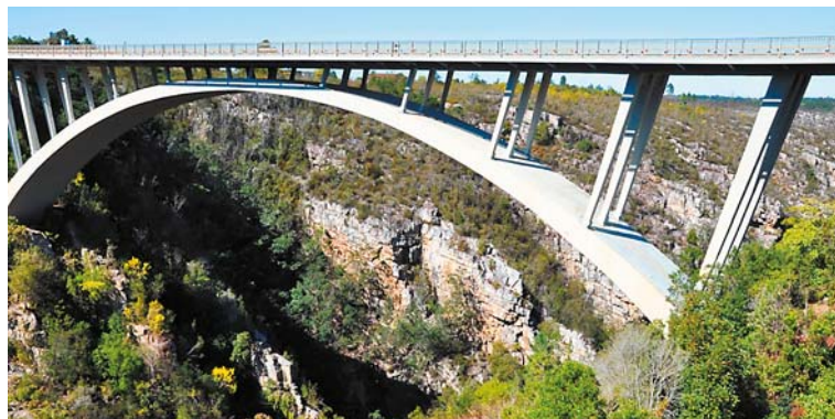
Most Storms Bridge. Betonowy most łukowy Storms Bridge w Afryce Południowej, proj. R. Morandiego – fot. prof. K. Flaga
