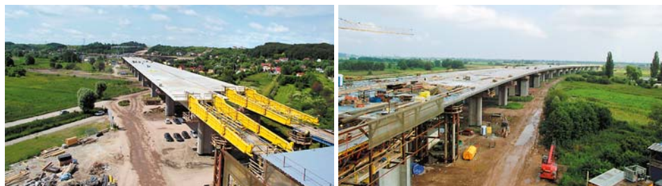
Estakada WE-1 w ciągu budowy drogi ekspresowej S7, odcinek Gdańsk (A1) – Koszwały, Południowa Obwodnica Miasta Gdańska
