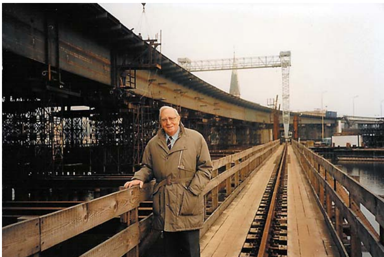
Prof. Andrzej Ryżyński, Przewodniczący ZMRP, na budowie mostu przez Parnicę w ciągu Trasy Zamkowej w Szczecinie, listopad 1995 r.
